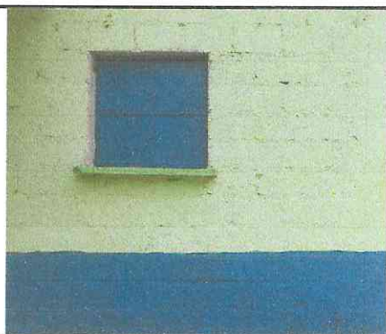
Matenimientos de ventanas de cocina.
