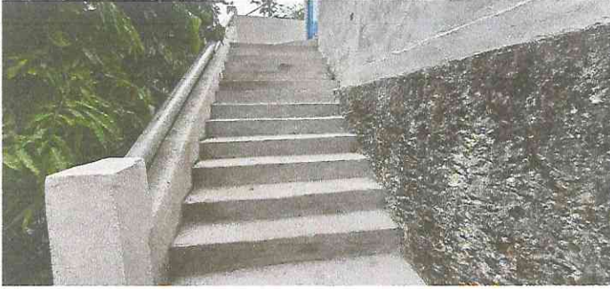
Reparacion de gradas de la entreda principal de la escuela.
