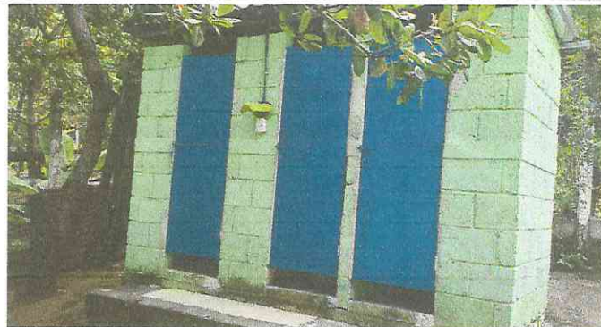
Sustitucion de Puertas de baños.
