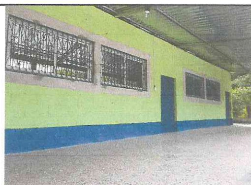
Mantenimiento de balcones en aulas.
